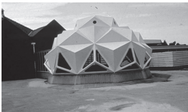
Figura 1.5 Estrutura em GFRP.
